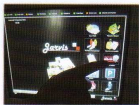
A partir d'un écran fixé au mur, quelques commandes suffisent à gérer l'appartement...
